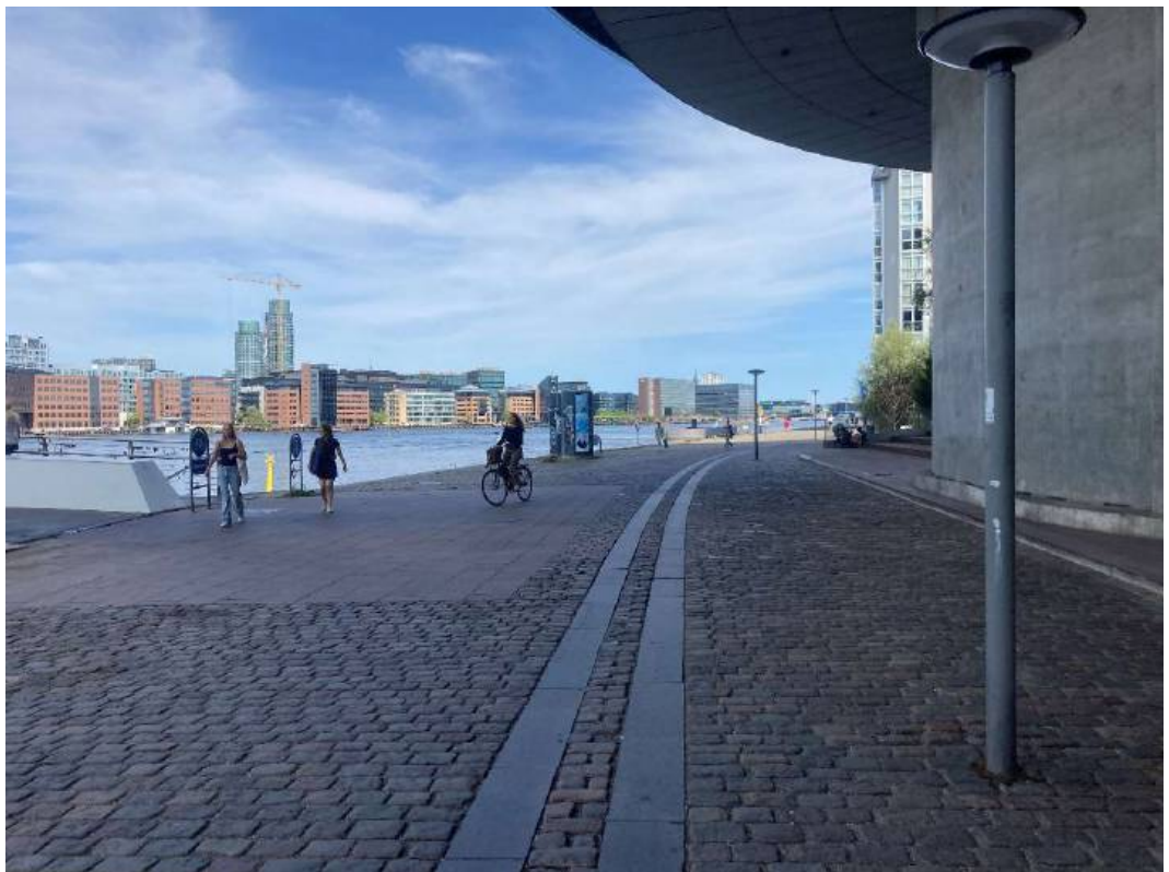
Figur 4: Foto af belægningen på Bryggebroens landing.
