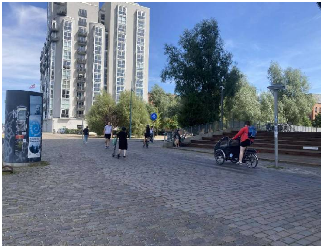
Figur 5: Foto af belægningen på Bryggebroens landing. På billedet ses forskellen på kløvede brosten og savede og jetbrændte brosten.
