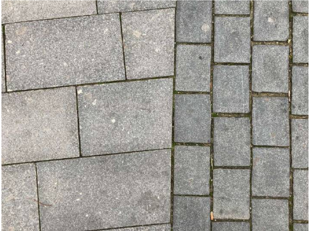
Figur 41: Eksempel på to granitbelægninger der adskiller sig fra hinanden ved at have forskellig læggeretning, fugestørrelse og stenstørrelse.
